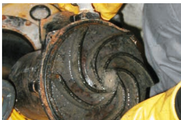
▶ Checking the impeller
